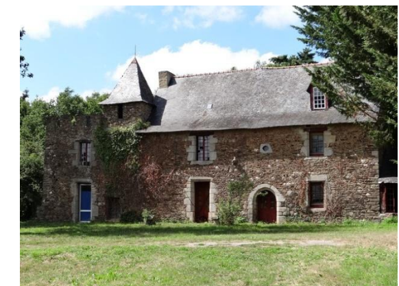
Photo 45 - Basse -cour du camp des Rouëts
